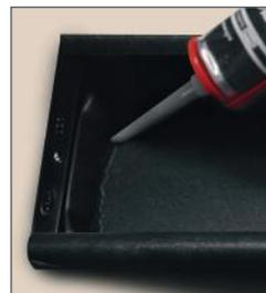
3 Anschließend wird der Endboden von innen mit einer Kleberaube wasserdicht versiegelt.
