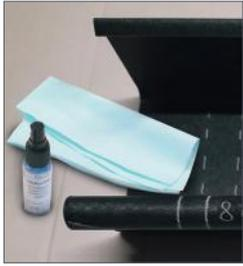
1 Klebbereich vor dem Reinigen anschleifen. Reinigen der Klebestellen mit dem haushaut-Haftreiniger empfohlen (im haushaut-Klebeset enthalten).
