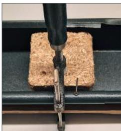
5 Rinnenverbindung mit einer Zwinde verpressen. Anschließend an der Rinnenwulst eine Niete zur Fixierung setzen.
